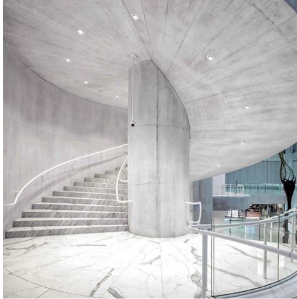
Gambar 2. 24 Beton Ekspos
