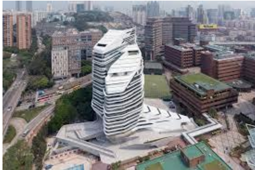
Gambar 2. 58 Bangunan JCIT yang Berada Diantara Bangunan Lama
